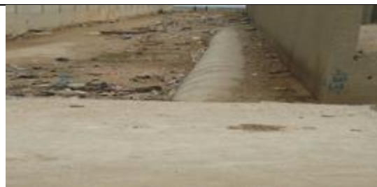
Photo 57 : canal d'eau pluvial traversant l'emprise
