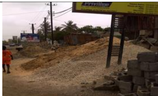
Photo 47: stockage des matériaux de construction dans l'emprise
